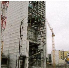
Übersicht: Abbruch von massiven, tragenden Stahlbetonteilen, nachdem ein Ersatztragwerk in Form eines Schwerlastgerüsts erstellt wurde.
