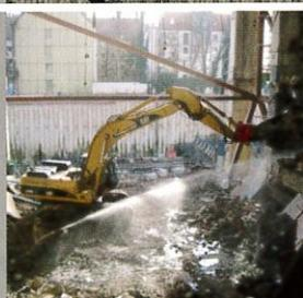
Aushöhlen des unteren Gebäudeteiles mit Hydraulikbagger, lärm- und erschütterungsarm durch Einsatz einer Betonschere.
