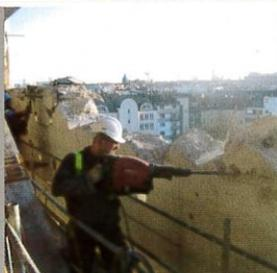
Hier im Detail: Handabbruch, unterstützt durch hydraulisches Vorsprengen, Ausführung ca. 30 Meter über Gelände.
