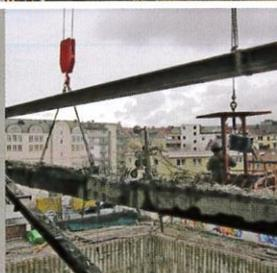
Auch in etwa gleicher Höhe wurde ein Alternativverfahren, das Seilsägen zur Durchtrennung von Stahlbeton und Abheben mittels Hochbaukran, angewandt.
