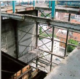
Demontage der im oberen Gebäudeteil befindlichen Elektro-Filteranlage. Im Hintergrund das bereits freigelegte Stahlskelett.
