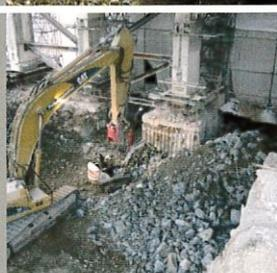
Abbruch der 1,80 Meter dicken Bodenplatte, nachdem die bestehen bleibenden Stützenfundamente vorab mittels Diamantsäge- und Bohrtechnik vom abzubrechenden Teil getrennt wurden.
