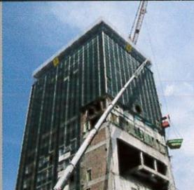
Rückbau der Fassade aus Drahtglasscheiben – teilweise ohne Gerüst vom Arbeitskorb aus.
